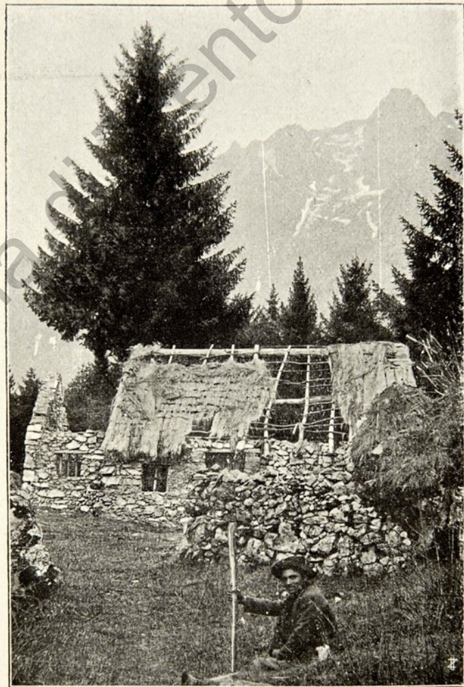
FIG. 23. — Le baite dei pascoli comunali, maltenute, ove vento ed acqua entrano liberamente. (Fot. bar. sen. G. Rossi - Schio).
